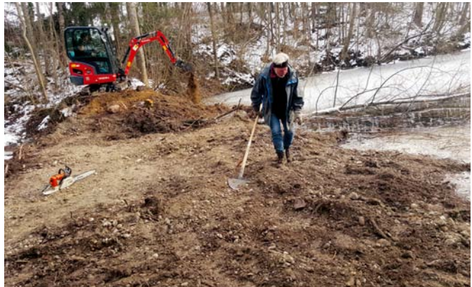
Umgestaltung des Uferbereiches zu Flachwasserzonen
